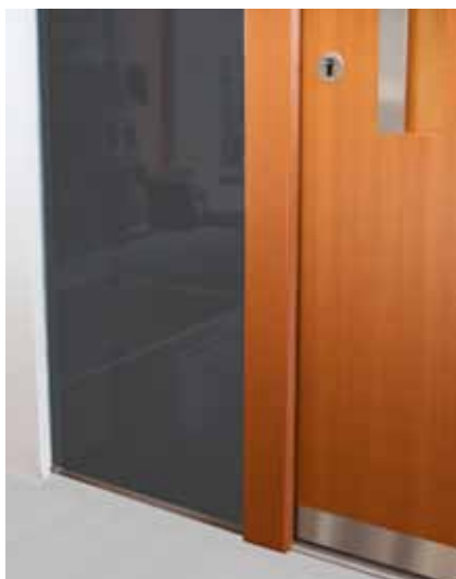
Okvir stranske svetlobe zunaj prekrit s fasado. Rob stekla ni viden. Spodaj inox zaključek.
